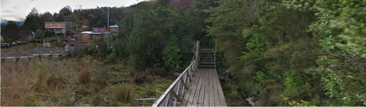
Imagen 13: Escaleras en sector Junquillo/Playa Ancha
