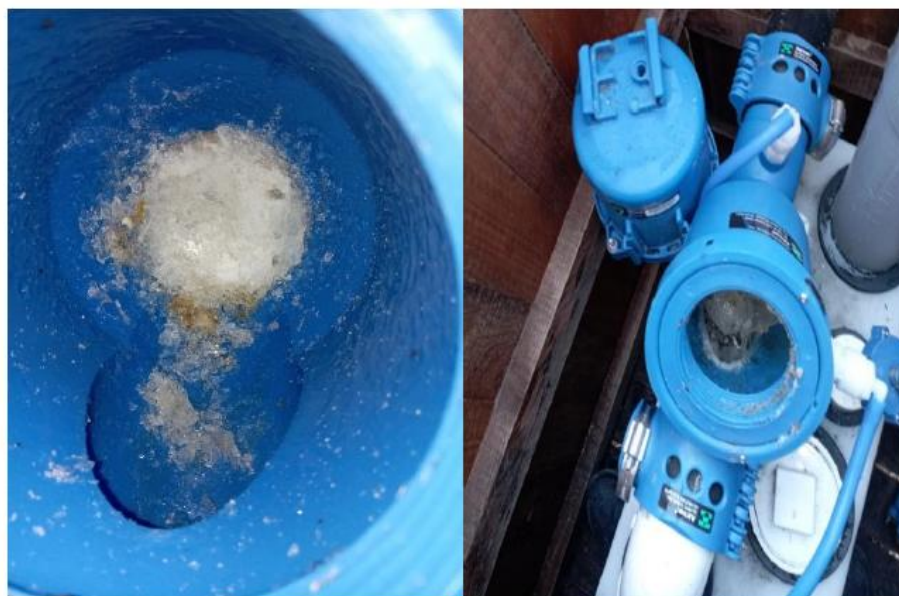
Figura n°1: Mejoramiento sistema de Alcantarillado
