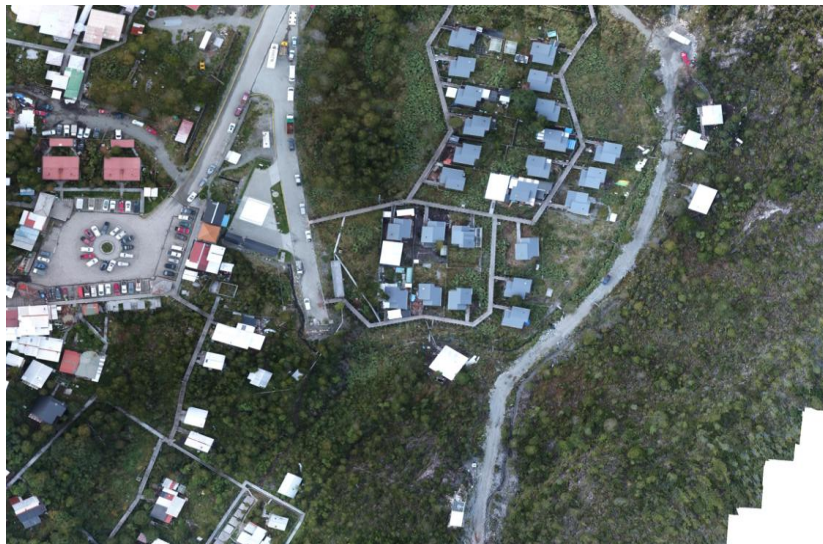
Figura nº2: Reposición Planta de Tratamiento
