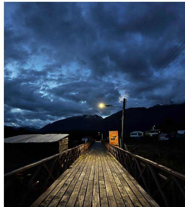
INSTALACIÓN DE SEÑALETICAS VIAL Y TURÍSTICA
