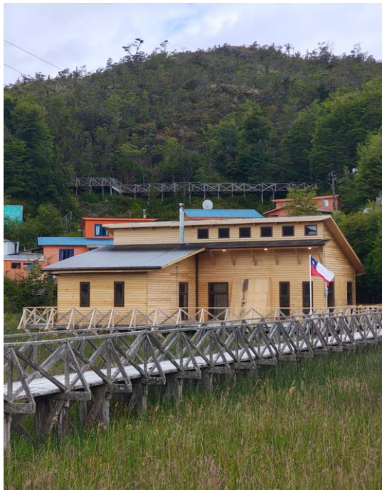
CONSTRUCCIÓN CENTRO COMUNITARIO
