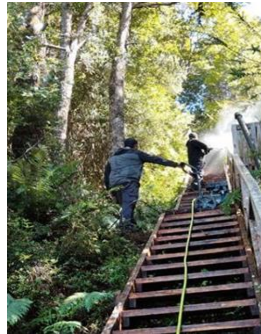
CONSERVACIÓN Y REPOSICIÓN PASARELAS
