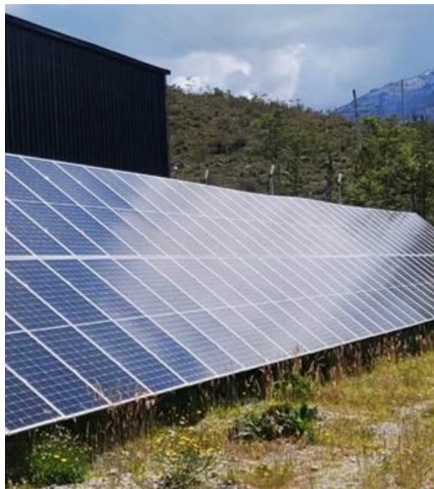
CONSTRUCCIÓN SISTEMA FOTOVOLTAICA
